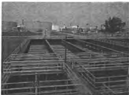
44-rasm. To'rtburchak birlamchi tindirgichlar.
